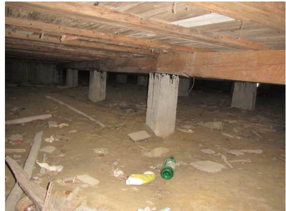
Kuva 18. Länsipäädyn puoleista ryömintätilaa.
