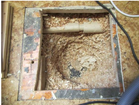
Kuva 23. RA3. Asbestia sisältäviä putkieristeitä.
