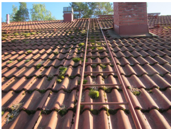
Kuva 47. Vesikatteen pinnalla sammalkasvustoa.
