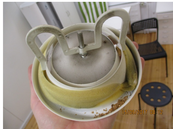
Kuva 76. Osassa C-rakennuksen poistoilmaventtiileissä on epätiivien kattoläpivienttien johdosta sahanpuruja venttiileissä.
