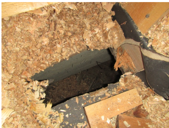
Kuva 21. RA1. Lahovaurioitunutta kannatin laudoitusta.
