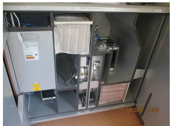
Kuva 72. Luokkahuoneiden ilmanvaihtokoneessa ei havaittu puutteita.
