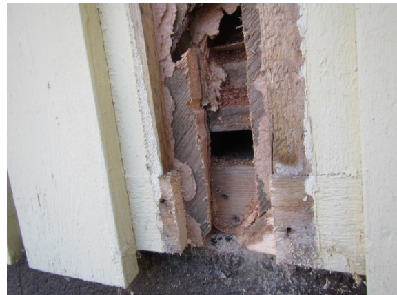
Kuva 39. RA8. Purueriste tummaa. Vahva viite vauriosta.
