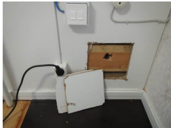
Kuva 41. RA8. Näyte ulkoseinästä, noin 500 mm lattiasta.
