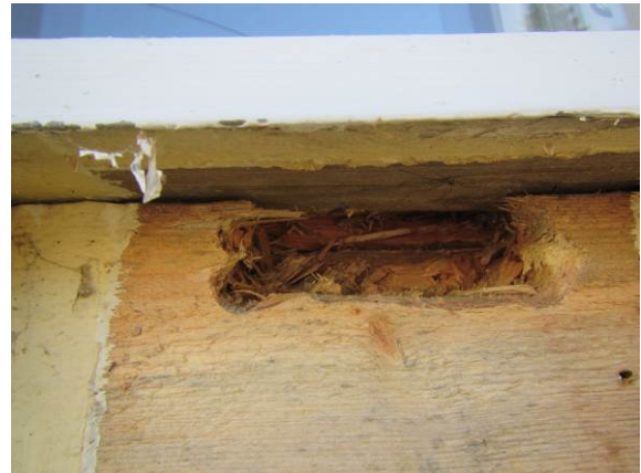
Kuva 44. Ikkunaliittymässä tilkkeenä pellavarivettä.
