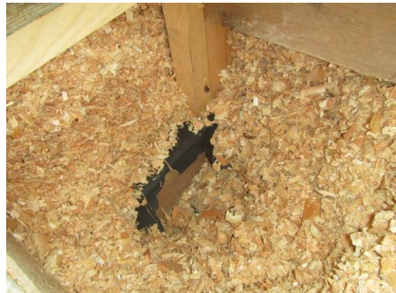
Kuva 26. RA9. Purueristeessä viite vauriosta.
