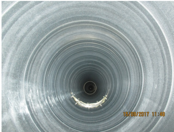
Kuva 67. Yleiskuva tuloilman runkokanavasta. Tuloilmakanavat ovat suhteellisen puhtaat.
