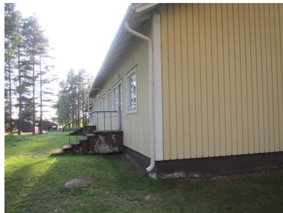
Kuva 8. C-osan rakennusvierustalla kallistus rakennukseen päin. Kattosadeveden ohjaus rakennuksen vierustalle.
