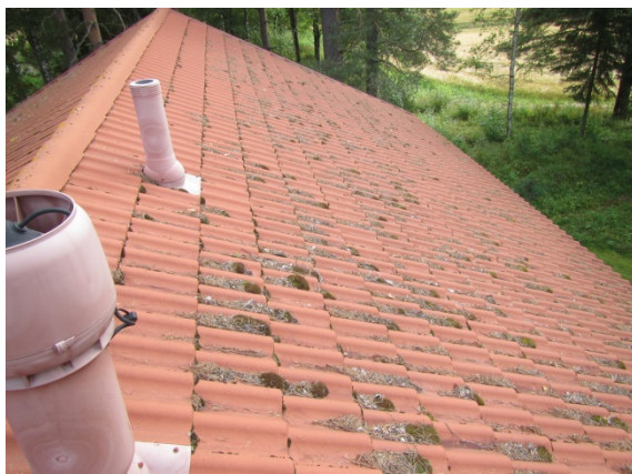
Kuva 55. Vesikatteen pinnalla sammalta.
