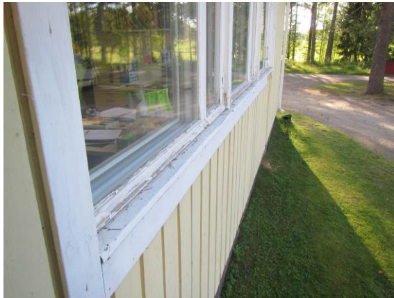
Kuva 43. Ikkunan vesipelti lyhyt ja kallistus rakennukseen päin.
