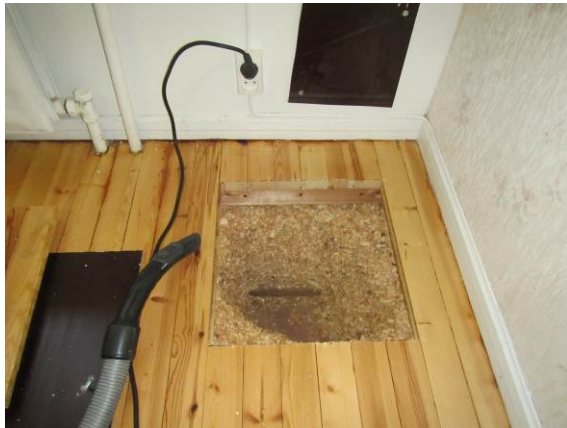
Kuva 34. RA5. Lattiarakenne ei ole tiivis.
