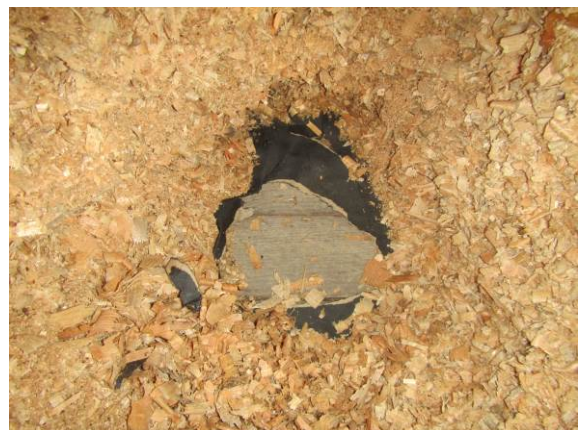
Kuva 30. RA1. Purueristeessä viite vauriosta.
