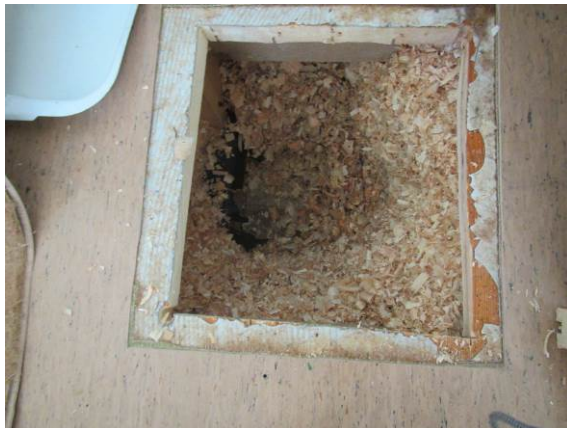
Kuva 25. RA9. Purueriste tummunutta alaosasta.
