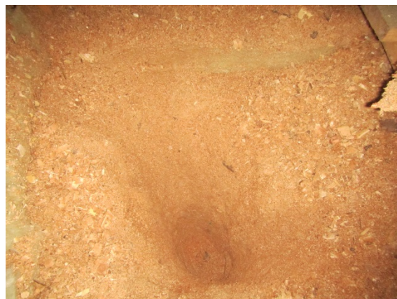
Kuva 54. Materiaalinäyte rakennuksen keskilinjan kohdalta eristetilan pohjalta.
