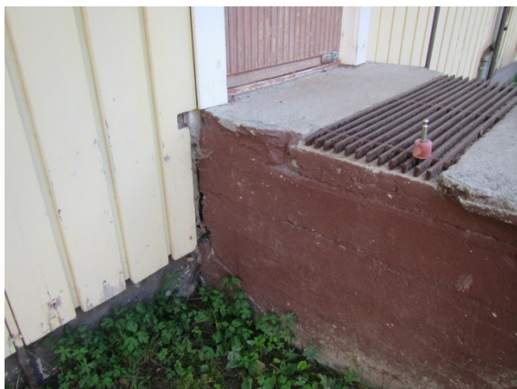
Kuva 42. Porrasrakenteiden kautta kosteusrasitusta ulkoseinärakenteeseen.
