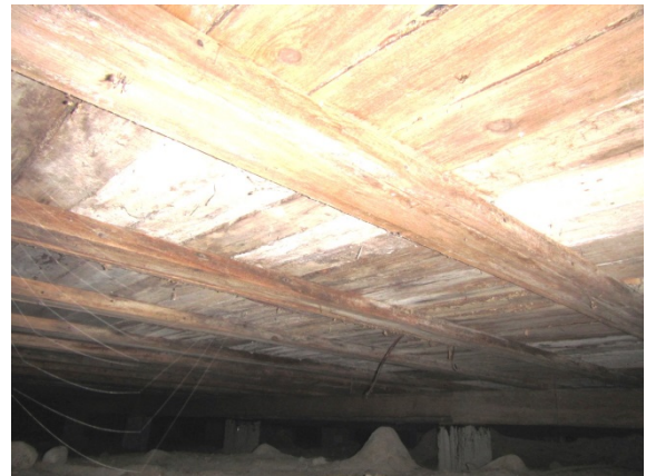
Kuva 20. RA1. Idän puoleista päätyä. Alapohjarakenne vaurioitunut.
