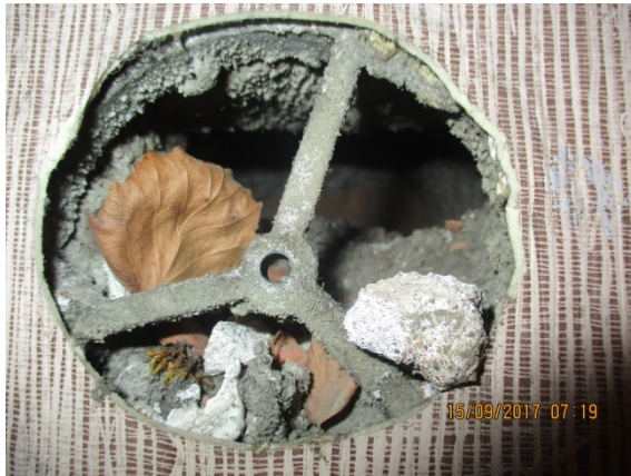
Kuva 73. A rakennuksessa on vanhoja painovoimaisen ilmanvaihdon venttiileitä, jotka ovat likaisia. Venttiilit tulisi olla tulppattu koneellisen poistoilmanvaihdon asennuksen yhteydessä.
