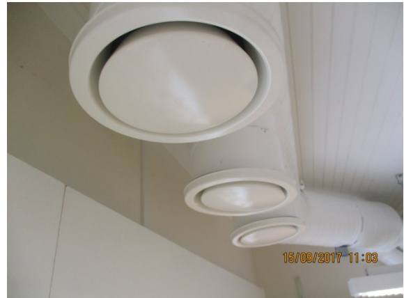
Kuva 68. Yleiskuva luokkahuoneen poistoilmapäätelaitteista.
