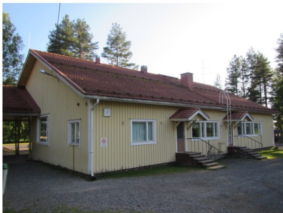
Kuva 7. Maanpinta viettää rakennukseen päin A-osalla.
