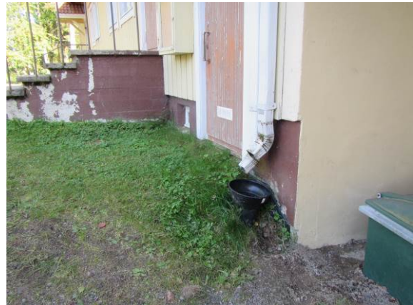
Kuva 10. Kattosadevesien ohjauksessa puutteita C-osalla. Kellarin kohdalla perusmuurissa patolevyä.
