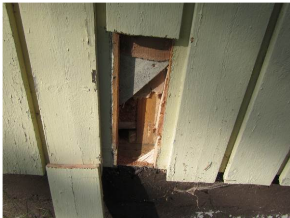
Kuva 40. RA4. Näyte ulkoseinän alaosasta. Purueristeessä viite vauriosta.
