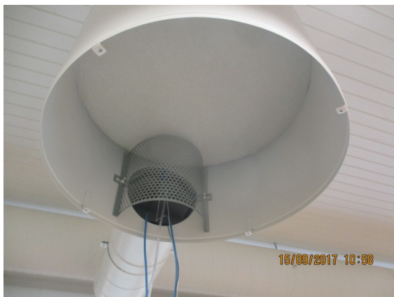
Kuva 65. Yleiskuva tuloilman päätelaitteesta. Tuloilmapäätelaitteet ovat suhteellisen puhtaita.
