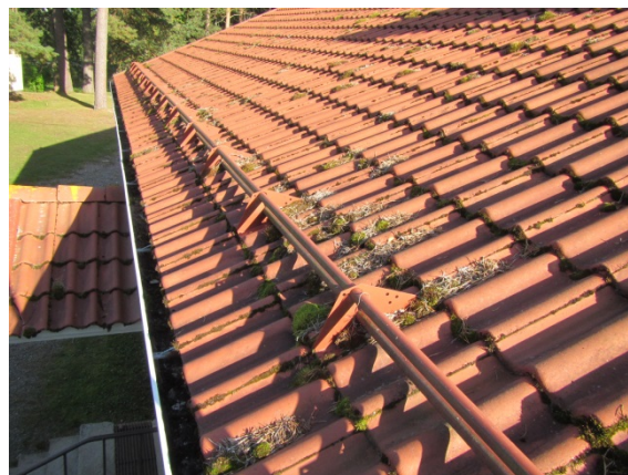
Kuva 48. Lumieste asennus. Laatat ovat ehjät.
