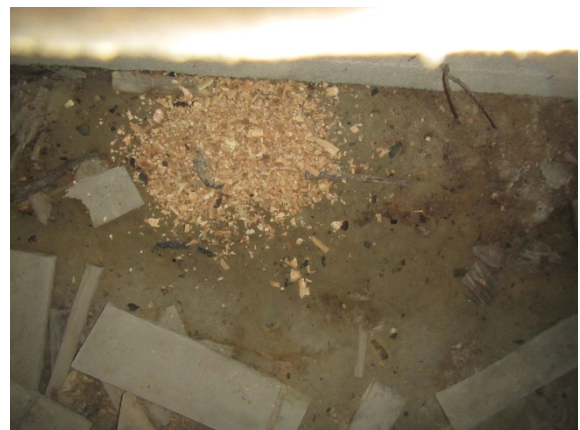
Kuva 22. RA1. Maapohjan pinnalla kasvustoihin viittaavaa tummentumaa.
