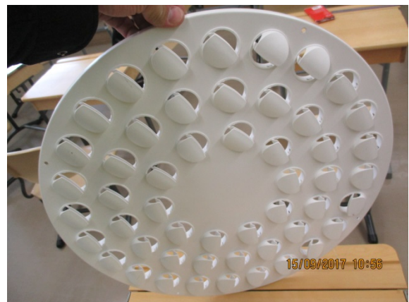
Kuva 66. Yleiskuva tuloilmasäleiköstä. Tuloilmasäleiköt ovat suhteellisen puhtaita..
