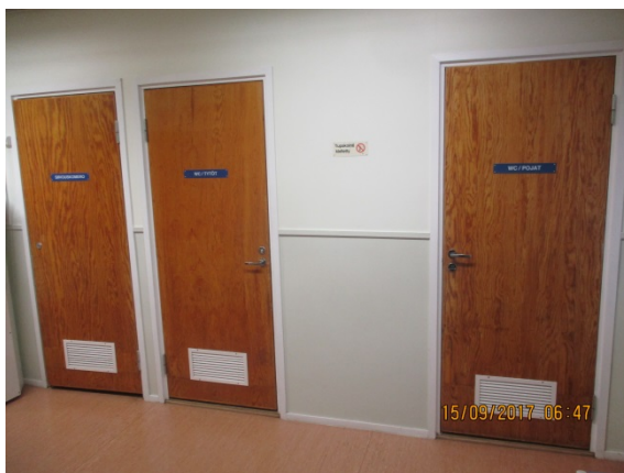
Kuva 71. A rakennuksen käytävän wc-tilojen oviin on asennettu siirtoilmäsäleiköt.
