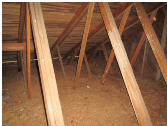
Kuva 50. Ullakko tuulettuu räystäältä.
