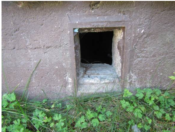
Kuva 17. Ryömintätilan tuuletusaukko. Suojaverkkoa ei ole.
