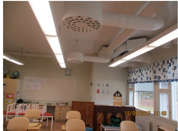
Kuva 62. Yleiskuva opetustilojen ilmanjakotavasta (A rak.).
