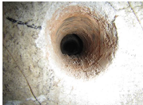
Kuva 14. Seinärakennetta tarkasteltiin porareian kautta.
