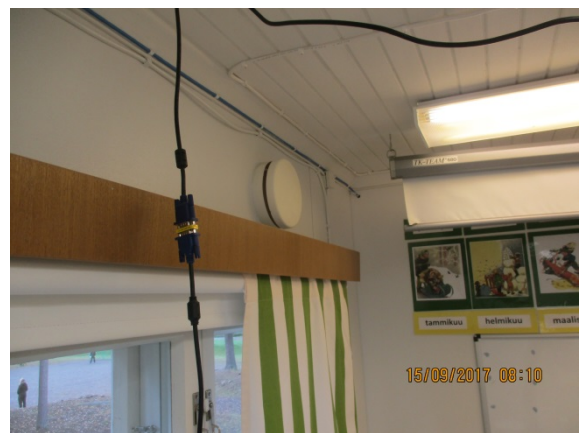
Kuva 64. Yleiskuva koneellisen poistoilmanvaihdon ulkoilmaventtiilistä.
