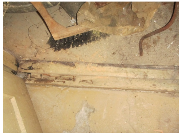
Kuva 2. Kosteus- ja mikrobivaurioitunut kynnyks.
