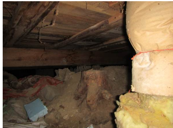
Kuva 28. RA1. Alapohjarakenne vaurioitunut tilan C05 kohdalta.
