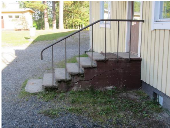
Kuva 9. Huonokuntoinen porras C-osalla.
