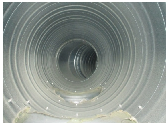
Kuva 70. Luokkahuoneiden poistoilman runkokanavissa on havaittavissa pölyä, mutta pölymäärä ei edellytä toimenpiteitä.
