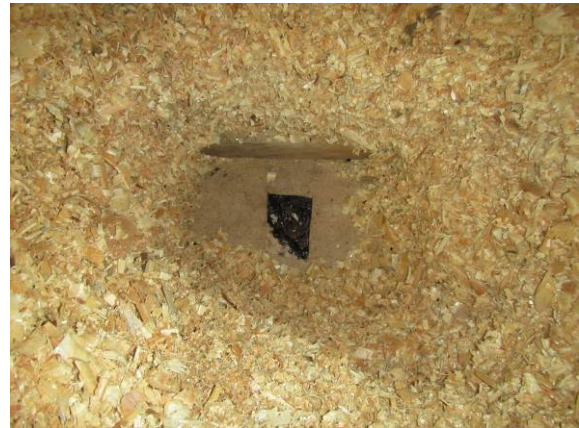
Kuva 35. RA5. Betonirakenteen pinnassa bitumisively.
