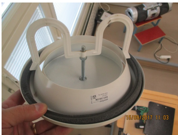
Kuva 69. Luokkahuoneen poistoilmaventtiilit ovat suhteellisen puhtaat.
