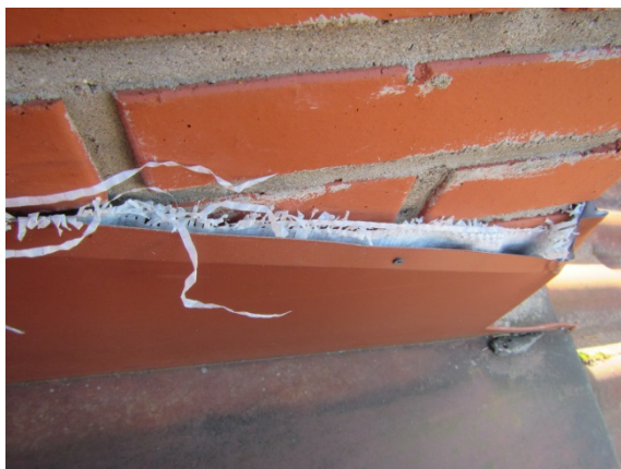
Kuva 49. Savupiipun rintapellin asennus ei ole tiivis.
