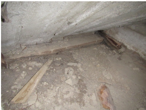
Kuva 3. Portaan alustilassa kosteus- ja mikrobivaurioitunutta puuta.
