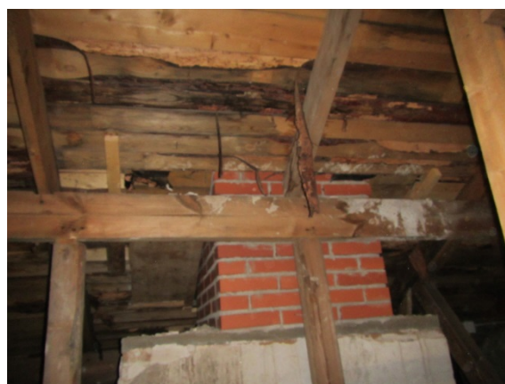
Kuva 52. Savupiipun kohdalla vesikatteen aluslaudoitus vaurioitunut.
