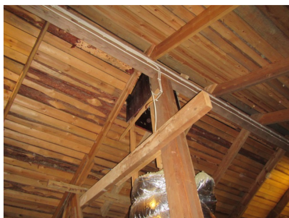
Kuva 51. Vesikattorakenteet ovat pääosin hyväkuntoiset.
