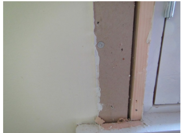
Kuva 46. C-osan lisälämmöneristettyä ulkoseinää/ ikkunaliittymä.
