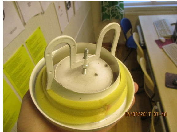
Kuva 74. Yleiskuva C rakennuksen poistoilmaventtiileistä.
