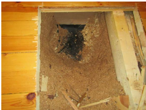
Kuva 31. RA3. Purueriste tummunutta, vahva viite vauriosta.
