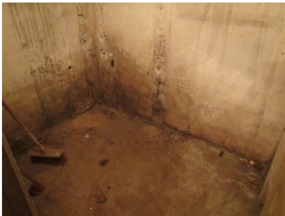
Kuva 1. Kellarikerroksen alapohjarakenteet ovat märät A-osalla. Seinillä kosteuden aiheuttamia tummentumia.
