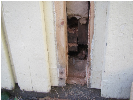
Kuva 38. RA5. Ulkoseinärakenne märkä. Maanpinta lähellä.
