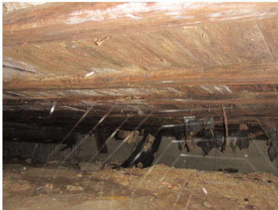
Kuva 19. Idän puoleista päätyä. Alapohjarakenne vaurioitunut pahoin.
