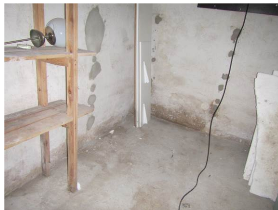
Kuva 6. Alapohjarakenteet märät.
