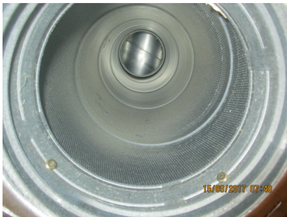
Kuva 75. C rakennuksen poistoilmakanavoinneissa on havaittavissa pölyä, mutta pölymäärä ei edellytä toimenpiteitä.
