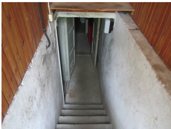
Kuva 5. Rakennus C:n kellaritiloihin käynti ulkokautta. Voimakas mikrobeihin viittaava haju.
