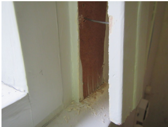
Kuva 45. Ikkunaliittymä suhteellisen tiivis.
