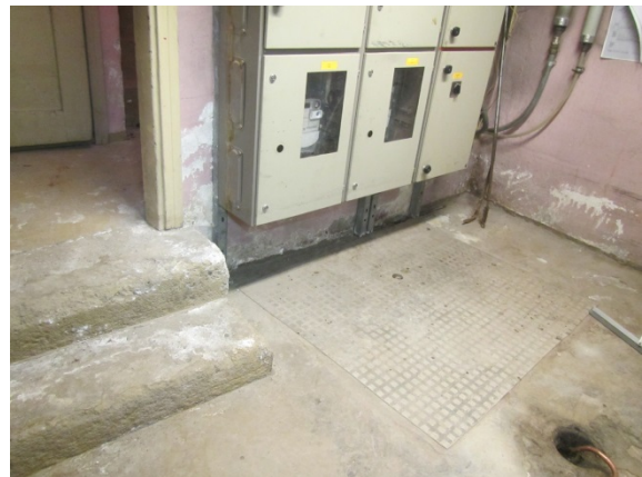
Kuva 4. Väliseinän alaosa märkä.
