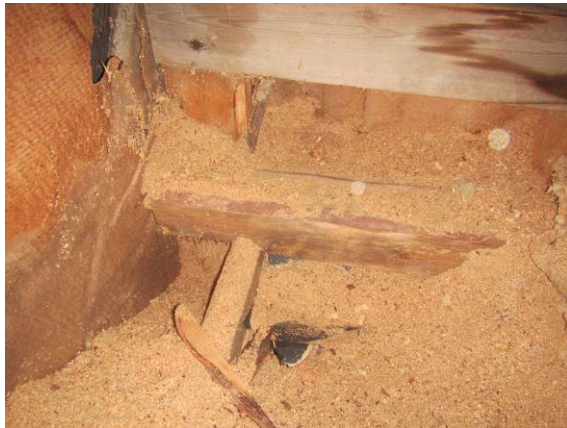
Kuva 59. Materiaalinäyte ulkoseinän vierustalta. Vuotokohdalla purueristeessä vahva viite vauriosta.
