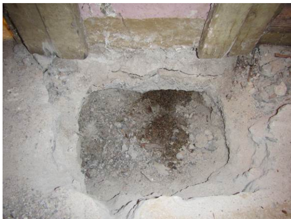
Kuva 13. Täyttöhiekka märkää alapohjan rakenneavauskohdassa.
