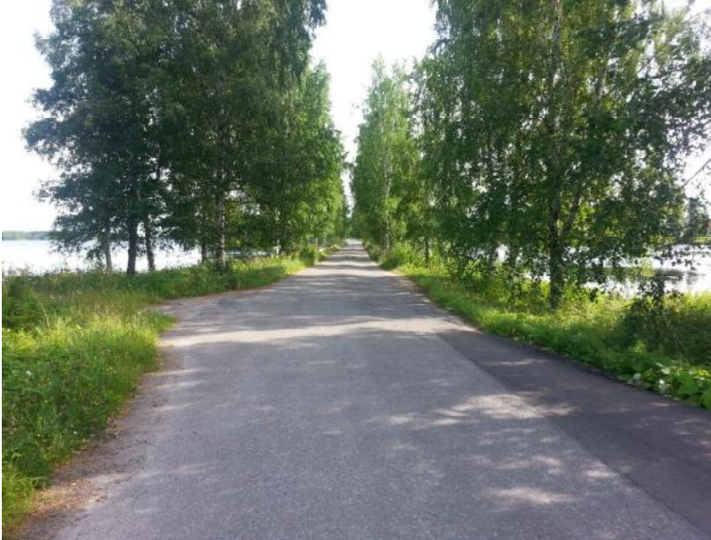
Kuva 6 Susisaarentie sillan alkupäästä kuvattuna
