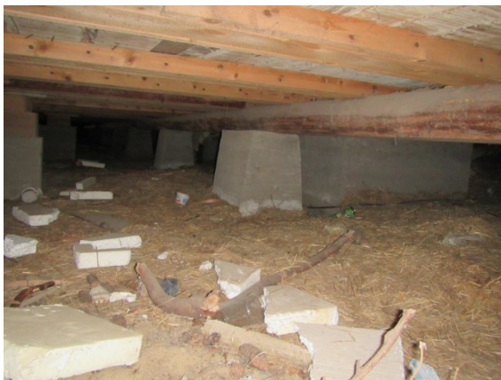
Kuva 12. Ryömintätilaa ryhmähuoneen kohdalta kuvattuna.
