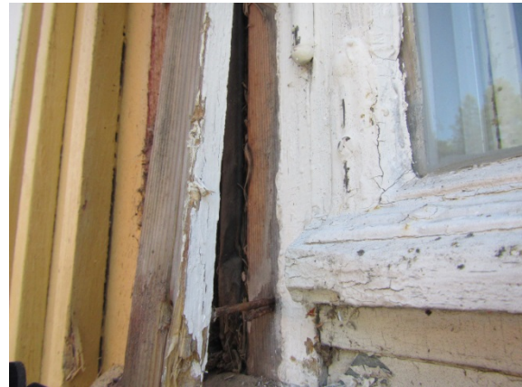
Kuva 21. Ikkunaliittymässä tiikemateriaalina kutterinlastua.
