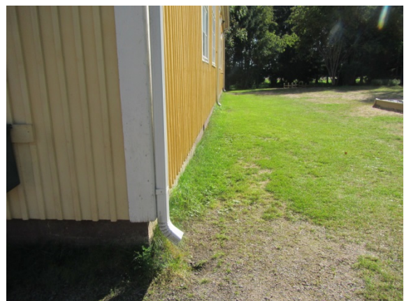
Kuva 6. Kattosadevedet ohjataan rakennuksen vierustalle.
