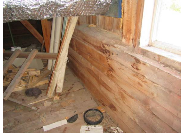
Kuva 30. Ikkunan kohdalla vesivuotojälkiä.
