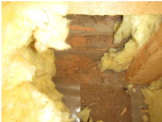
Kuva 18. RA2. Hirsirungon alaosissa lahovaurioita.
