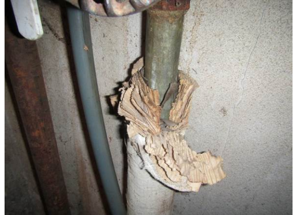
Kuva 2. Asbestia sisältävää putkieristettä.
