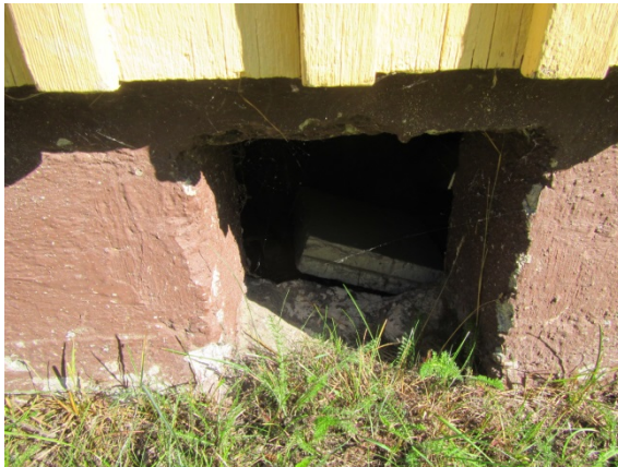
Kuva 10. Sokkelin tuuletusaukko.
