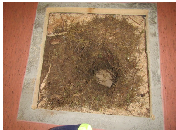
Kuva 15. RA6. Sammaleristeessä vahva viite vauriosta. Voimakas hajua.
