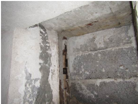
Kuva 3. Ikkunaliittymä suljettu kevytsoraharkolla. Kohdalla kosteus- ja mikrobivaurioitunutta tukilaudoitusta.
