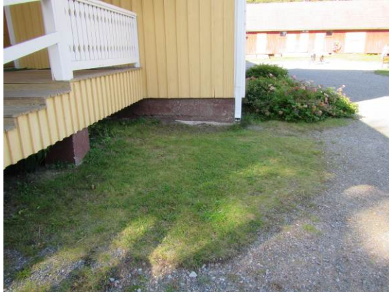
Kuva 7. Paikoin maanpinnan kallistuksissa puutteita.
