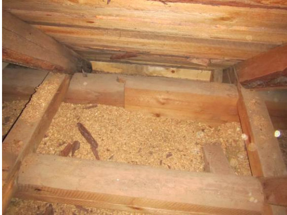
Kuva 29. Räystäsrakenne tiivis.
