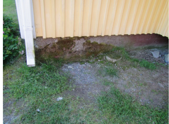
Kuva 8. Sokkelirakenteen kohdistuu kosteusrasitusta
