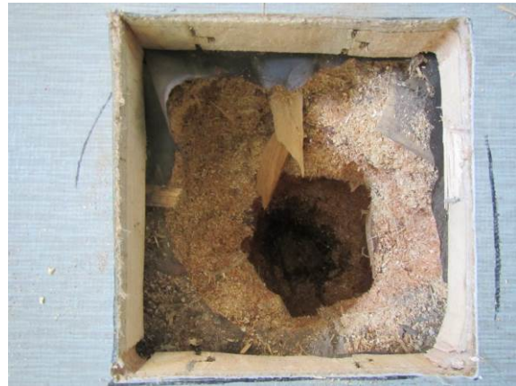
Kuva 25. Avauskohdassa ei viitettä vauriosta.
