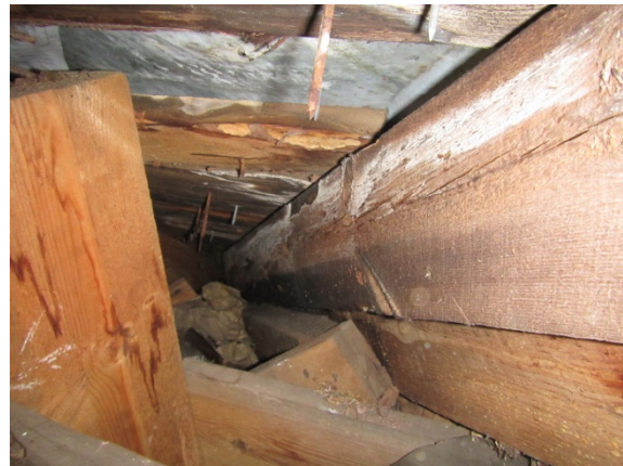
Kuva 28. Jiiritaitteen kohdalla vesivuotojälkiä.
