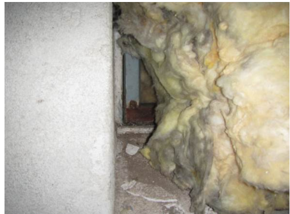
Kuva 4. Ikkuna on peitetty mineraalivillalla.
