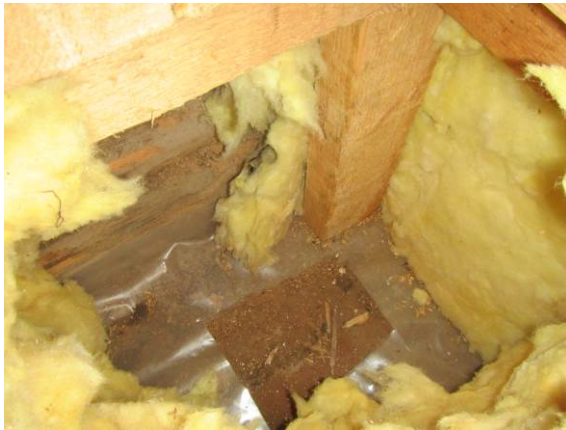
Kuva 24. Betonirakenteen ja muovin välissä orgaanista materiaalia.
