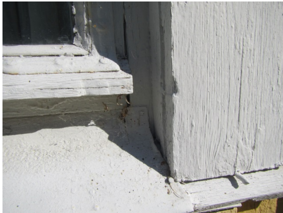
Kuva 20. Ikkunan vesipellin asennus ei tiivis.
