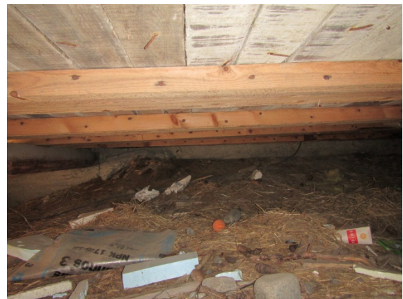
Kuva 13. Ryömintätilaa ryhmähuoneen kohdalta kuvattuna.
