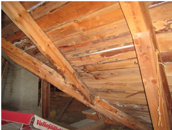
Kuva 27. Vesikattorakenteessa vesivuotojälkiä.
