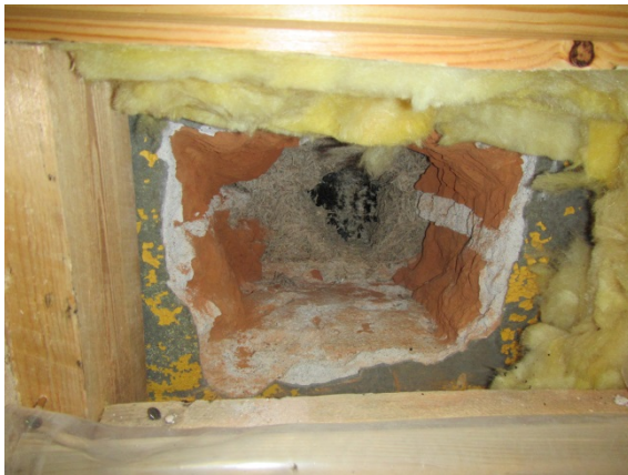
Kuva 15. RA1. Lämmöneristeinä kuorimuurauksen takana alkuperäinen toja-levy.
