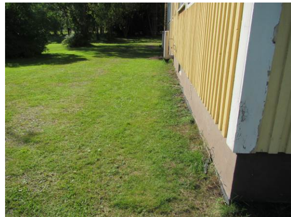
Kuva 7. Maanpinta viettää paikoin rakennukseen päin.
