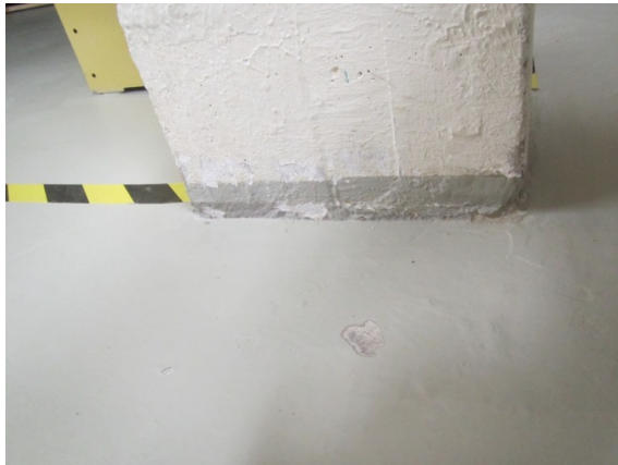
Kuva 3. Teknisen työn tilassa pilareiden alaosien pintakosteuden vertailuarvot ovat korkeat
