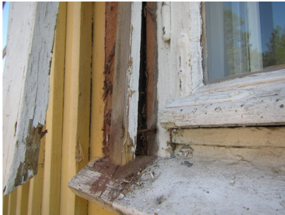
Kuva 31. Ikkunan vesipellin asennus puutteellinen.
