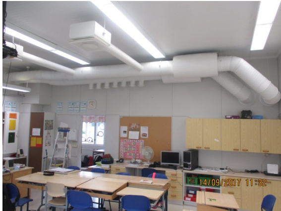
Kuva 43. Yleiskuva perusopetustilasta (44,5m 2 ).
