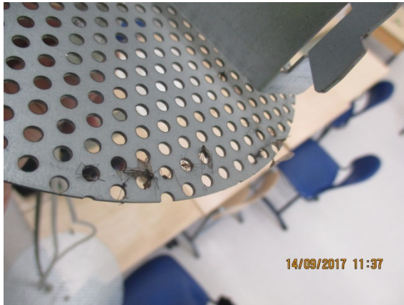
Kuva 47. Perusopetustilojen tuloilmapäätelaitteiden säätöosissa on hyönteisiä.
