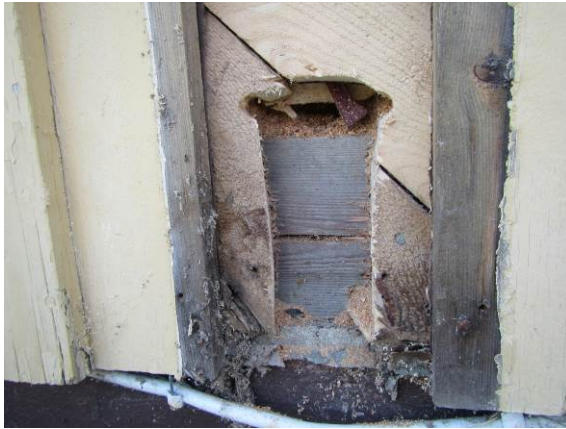
Kuva 29. Ulkoseinän rakenneavauskohta. Purueriste tummaa.
