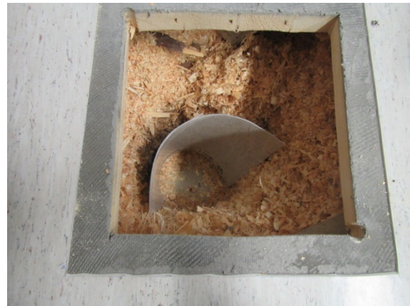
Kuva 26. RA14. Purueristeessä ei värimuutoksia.
