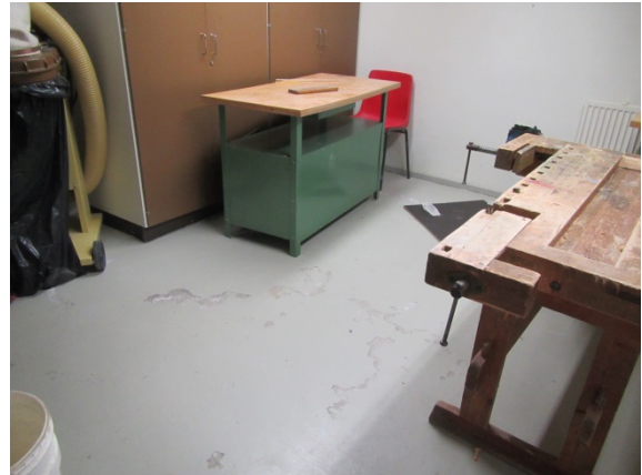
Kuva 2. Teknisen työn lattian maalipinta hilseilee ja pintakosteuden vertailuarvot ovat korkeat.
