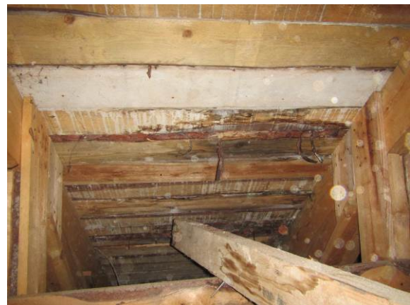
Kuva 36. Vesivuotojälkiä katossa.
