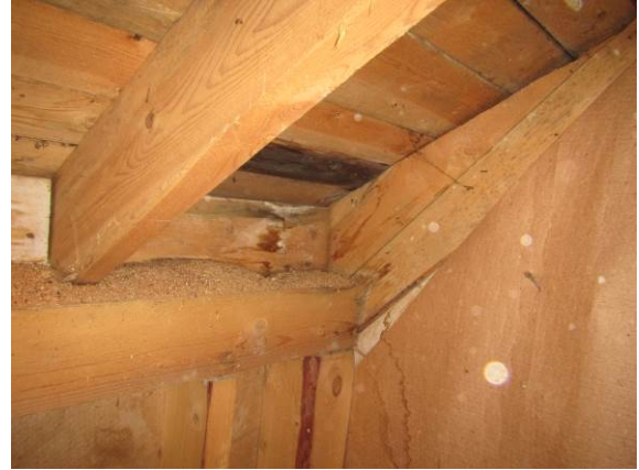
Kuva 34. Vesivuotojälkiä.
