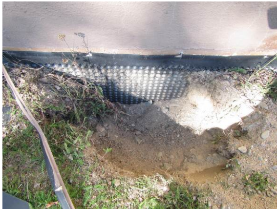
Kuva 8. Perusmuuria vasten patolevyä.
