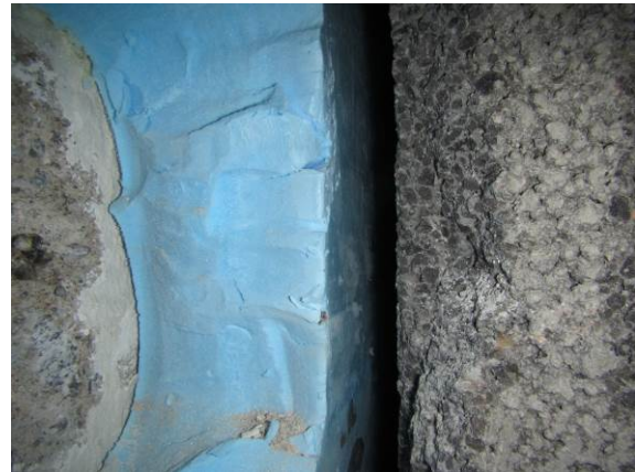
Kuva 20. RA7. Rakenteessa lisälämmöneristys.
