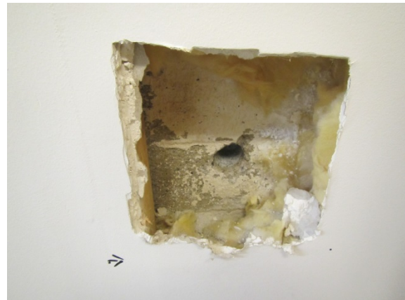
Kuva 16. RA2. Lisälämmöneriste mikrobivaurioitunut.
