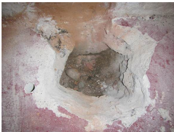
Kuva 21. RA8. Täyttöhiekka kostea.
