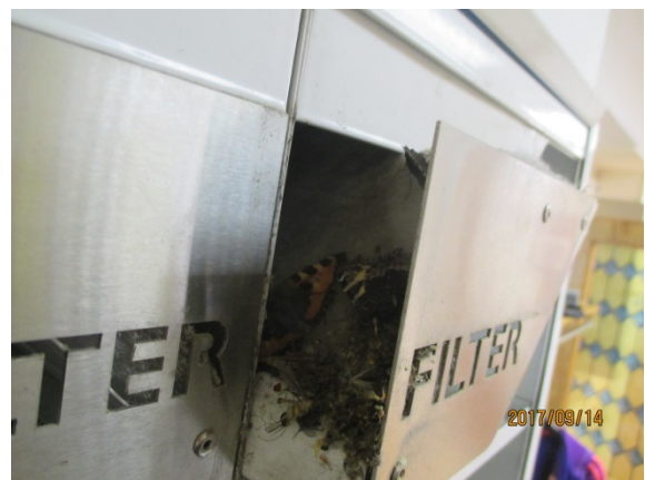
Kuva 56. Ilmanvaihtokoneiden suodattimissa on runsaasti hyönteisiä.
