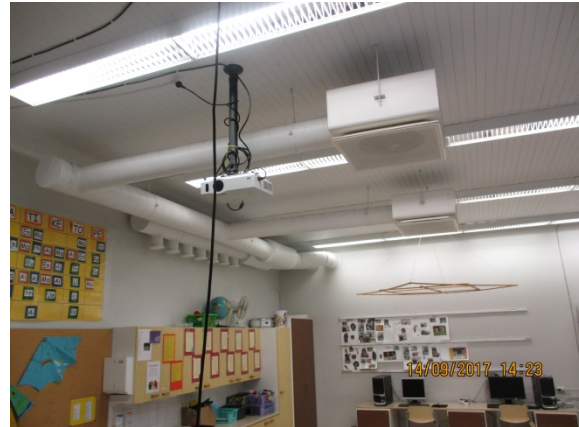
Kuva 44. Yleiskuva perusopetustilasta (57,4m 2 ).
