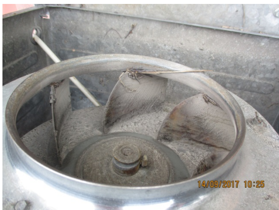
Kuva 57. Huippuimureiden puhaltimissa on epäpuhtauksia.
