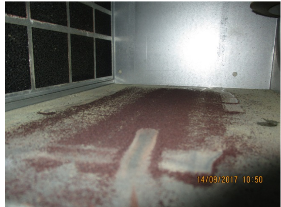
Kuva 54. MUH tuloilmanlämmittimien sisällä on runsaasti epäpuhtauksia.
