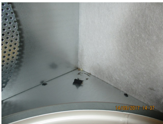
Kuva 49. Perusopetustilojen tuloilmapäätelaitteiden painetasauslaatikoissa on roskaa.
