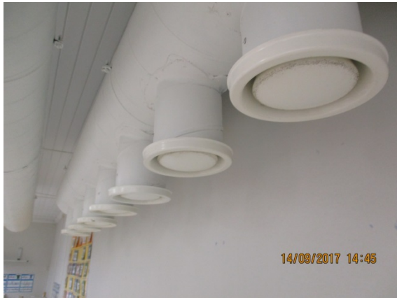
Kuva 53. Kiinteistön poistoilmaventtiileiden pinnassa näkyy selvä epäpuhtauskertymä.
