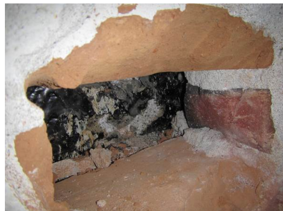
Kuva 22. RA8. Betonirakenteen pinnassa bitumisively.
