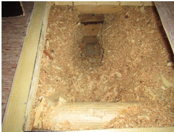
Kuva 25. RA9. Lämmöneristeenä on sahanpurua.
