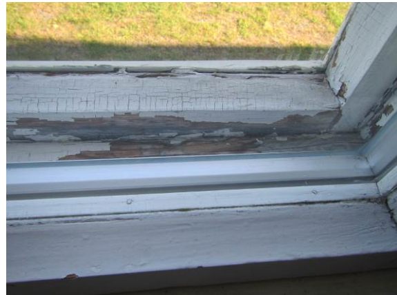
Kuva 32. Ikkunat ovat huonokuntoiset.
