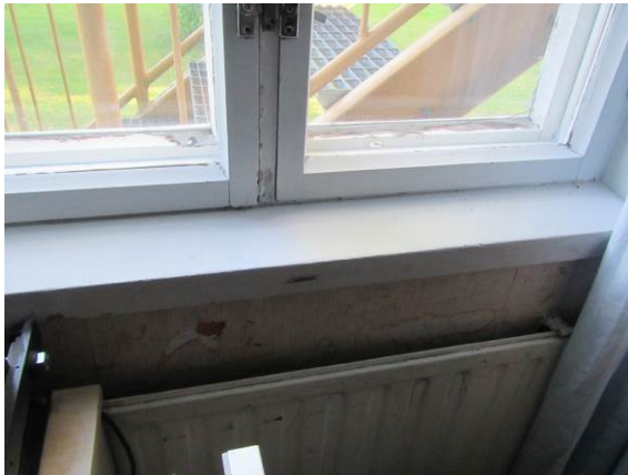
Kuva 5. Mon/opett -tilassa ikkunan alapuolella tapetissa kosteuden aiheuttamiksi viittaavia jälkiä.
