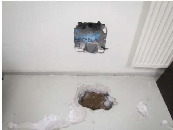
Kuva 19. RA6, RA7. Alapohjarakenteen täyttöhiekka märkää. Kosteus nousee kapillaarisesti alapohjarakenteeseen.
