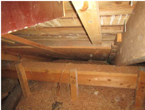
Kuva 37. 2. kerroksisen osan viistoa osuutta. Tuuletusraon toimivuudesta ei saatu varmuutta.
