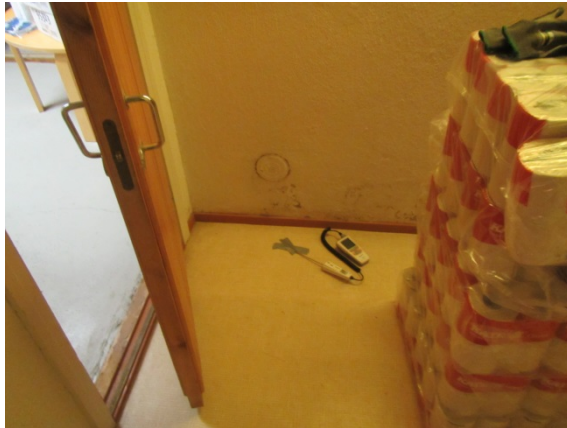
Kuva 1. Kellarikerroksen käytävän sisäilmassa kemiallista hajua viitaten lattiapinnoitteen VOC-vaurioon.
