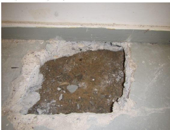
Kuva 17. RA3. Täyttöhiekka aistinvaraisesti arvioituna märkää. Kevyt väliseinä lähtee laatan päältä.
