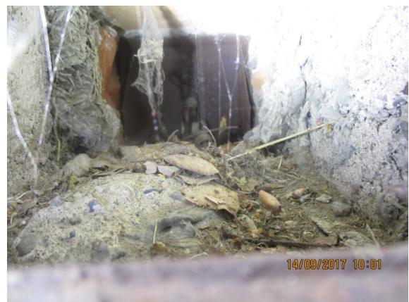
Kuva 52. Kellarin rakenneaineiset korvausilmareitit ovat huonokuntoiset ja epäpuhtaat.
