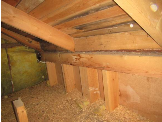
Kuva 33. Rästään kohdalla vesivuotojälkiä ja kosteuden aiheuttamia tummentumia. Kuva ullakolle oven edustalta. Rästäs rakenne on tiivis.
