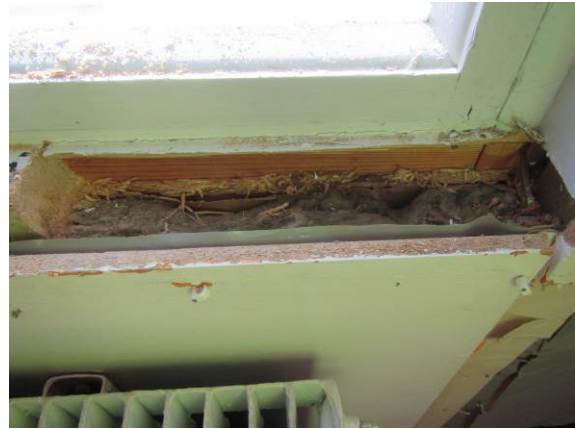
Kuva 30. Ikkunaliittymän kohdalla rakenne ei ole tiivis.
