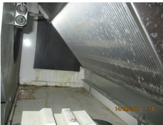
Kuva 55. Ilmanvaihtokoneiden kammioiden sisäpinoilla on epäpuhtauksia.
