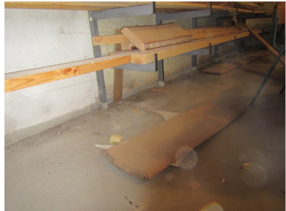
Kuva 4. Varastotilan lattian pintakosteuden vertailuarvot korkeat.
