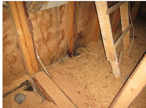
Kuva 38. 2-kerroksisen osan päädyssä kosteusjälkiä.
