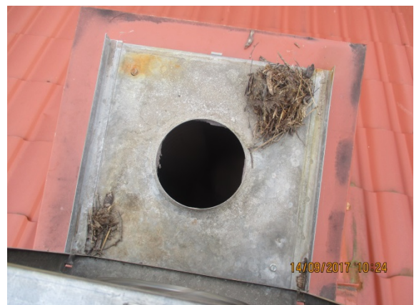
Kuva 58. Huippuimurin sisällä oli linnunpesä.
