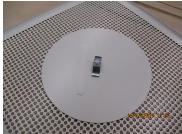
Kuva 48. Perusopetustilojen tuloilmasäleiköistä erottuu pyyhkäisykokeella pölykerros.
