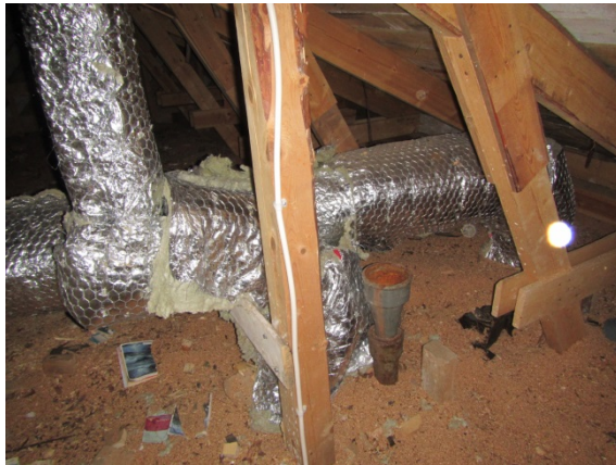
Kuva 39. 2-kerroksista osaa. Valurautaviemärin pää.
