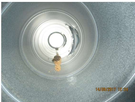
Kuva 51. Harjoitusruokalan tuloilmakanavassa on epäpuhtauksia (hyönteisiä, sahanpurua).
