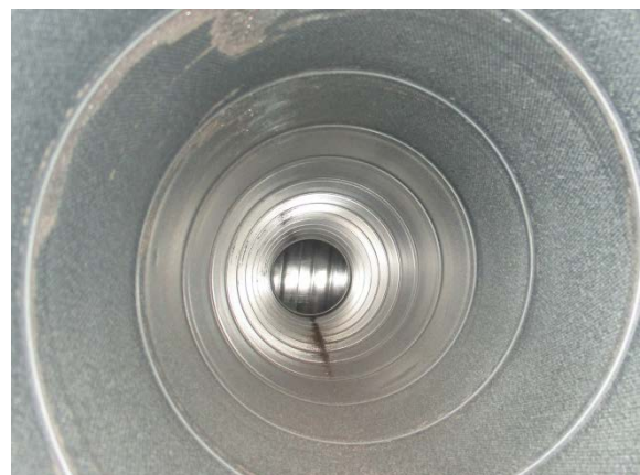
Kuva 50. Perusopetustilojen tuloilmakanavassa on yhtenäisen epäpuhtausjana kanavan pohjalla.
