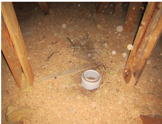
Kuva 35. Vesivuotojälkiä purueristeen pinnalla 1-kerroksisen osan luokkatilan kohdalta.
