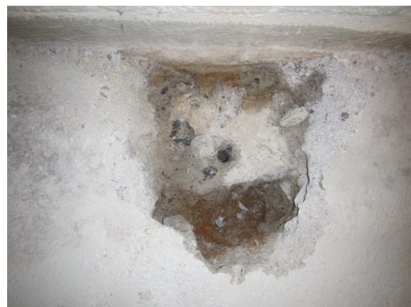
Kuva 18. RA4. Perusrakenne ja täyttöhiekka märkää.
